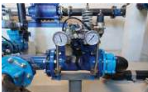
Válvula de Controlo Hidráulico/Antecipadora de Vaga DN 250 PN 16 na Elevatória RE22 Fraião Igreja.
