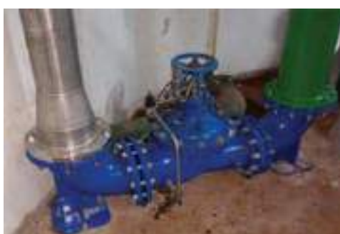
Válvula de Controlo Hidráulico/Antecipadora de Vaga DN 250 PN 16 na Elevatória RE2 Picoto de Baixo
