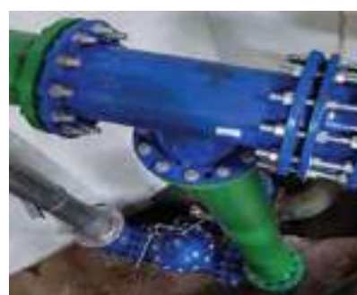
Válvula de Controlo Hidráulico/Antecipadora de Vaga DN 250 PN 16 na Elevatória RE2 Picoto de Baixo
