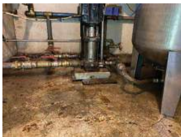
Instalação predial – – Fuga no grupo de bombagem
