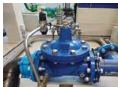
Válvula de Controlo Hidráulico/Antecipadora de Vaga DN 250 PN 16 na Elevatória RE22 Fraião Igreja.
