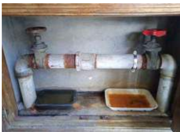
Instalação predial – – Fuga em ramal
