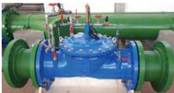
Válvula de Controlo Hidráulico de 14" ANSI 300 (DN350 PN40) Grupo Principal GP1 de elevação para o Reservatório de Montariol
