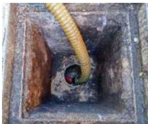
Separador de Gorduras (após limpeza)
